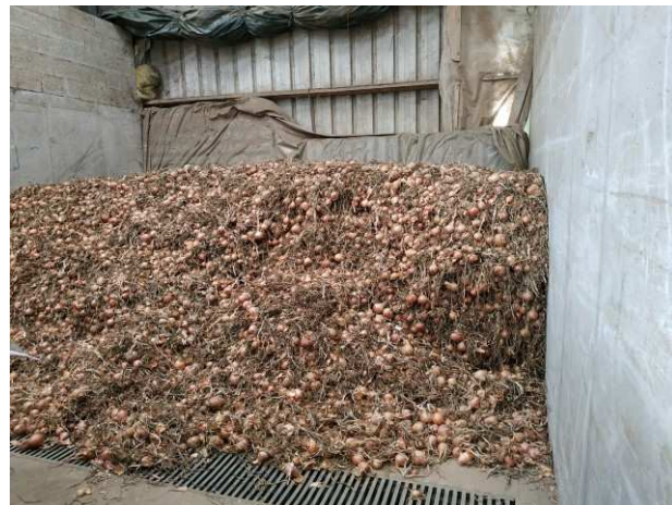
Silo avec gaines de ventilation (Photo CA BZH)
